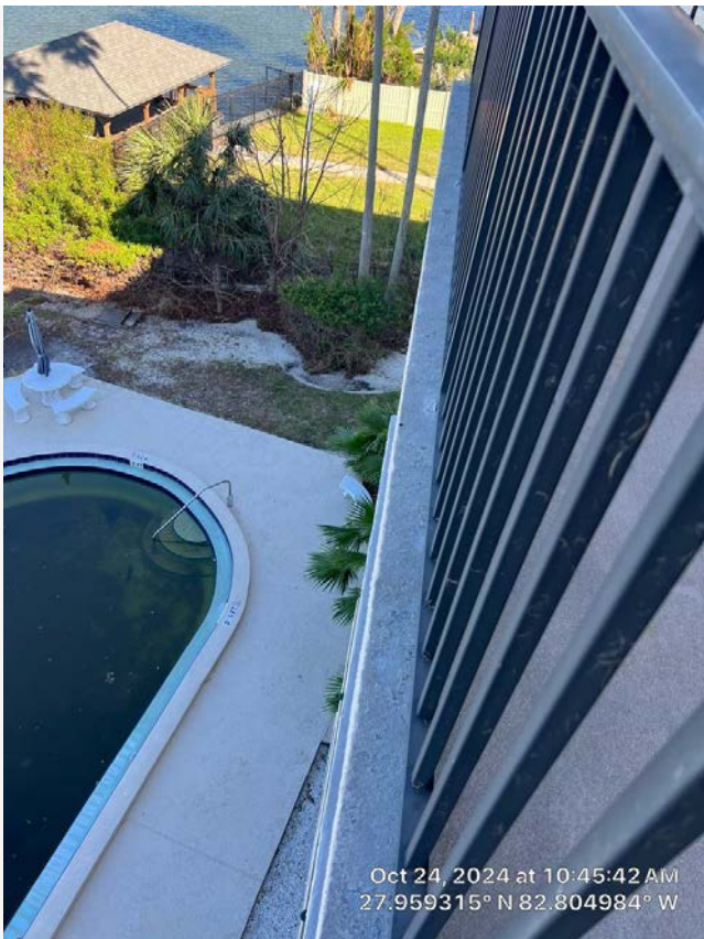
Balcony slab edge Unit 14.
